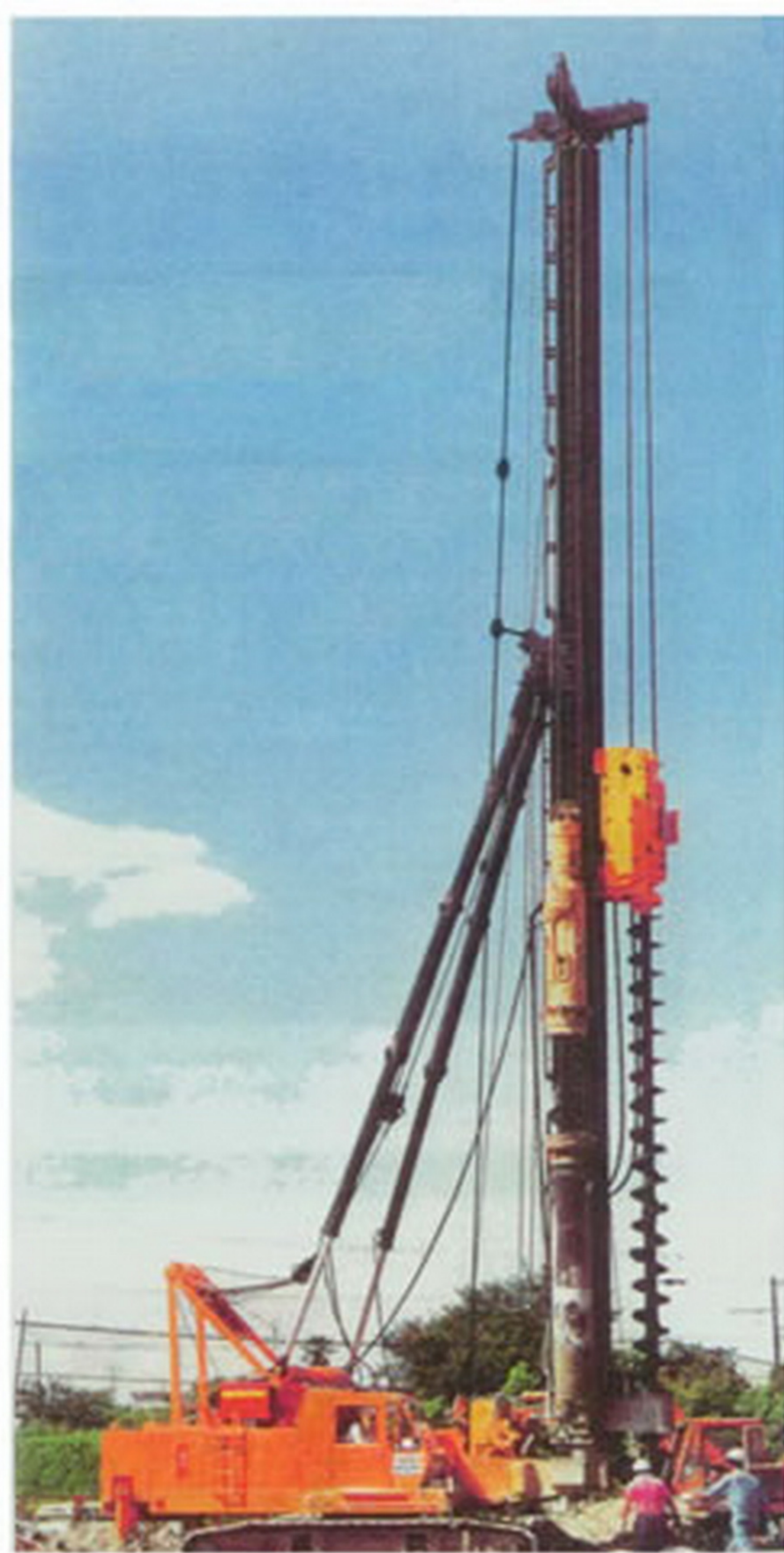
DHP-80 выполняет погружение готовой сваи
